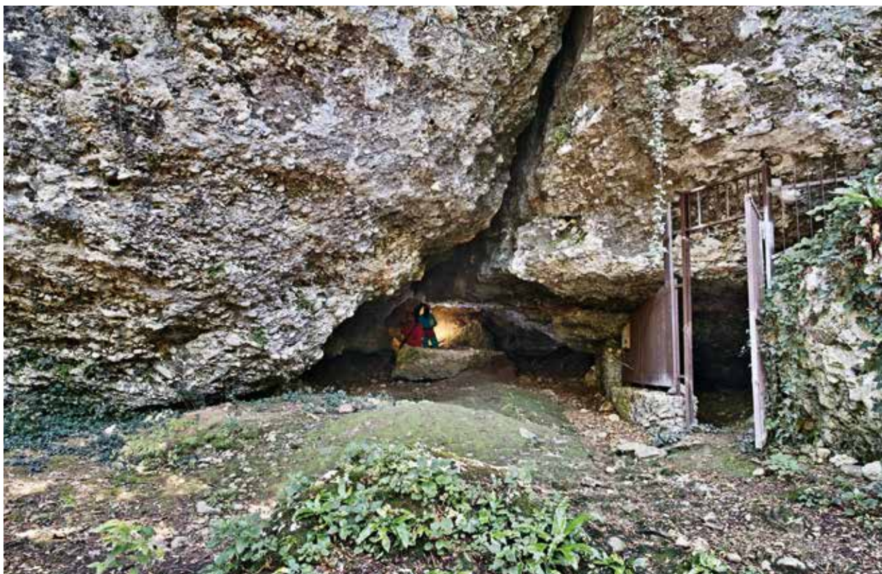
21 > I conglomerati fluviali nei quali si apre il Riparo di Biarzo (San Pietro al Natisone): è evidente la frattura che ha portato al crollo di parte della volta del riparo.
