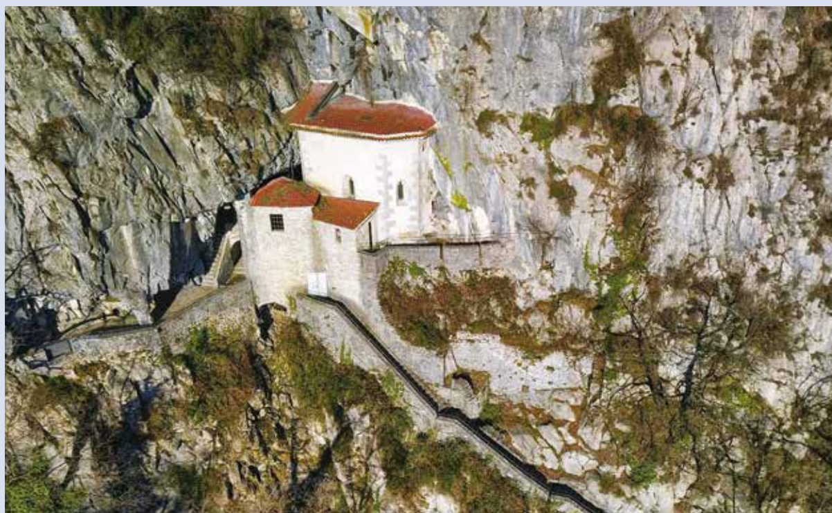
123 > La chiesa e le altre strutture all'ingresso della Grotta di San Giovanni d'Antro (Pulfero).
